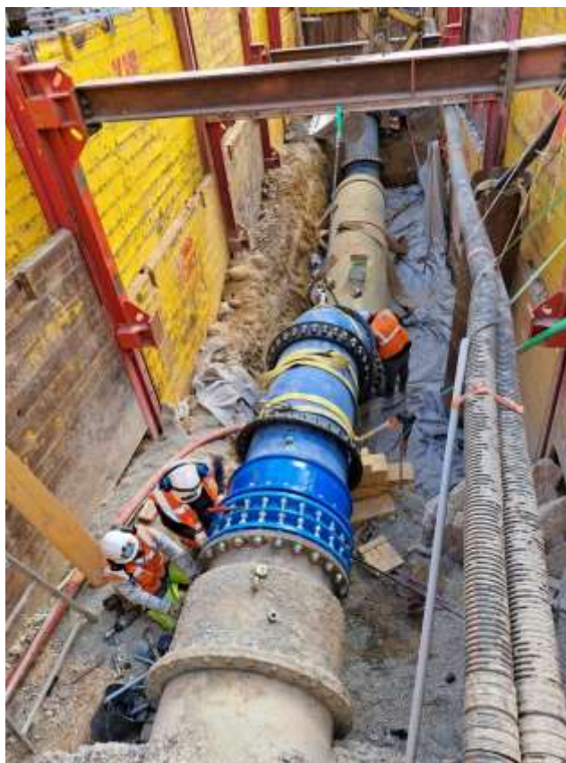
Nîmes - Boulevard du Président Salvador Allende Création d'une baïonnette sur un adducteur d'eau potable diamètre 800 mm (335 k€ TTC) Raccordement au réseau existant
