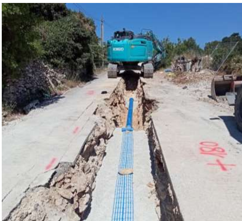
Nîmes - Chemin de la Cigale Extension du réseau d' eau potable (780k€ TTC) Atelier de terrassement, pose et remblai en tranchée ouverte
