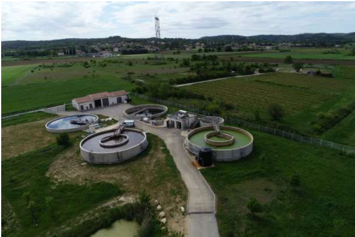
Tranches 1 et 2 de la STEU de La Gardonnenque – en service
