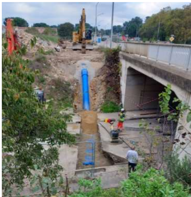
Nîmes - Boulevard des Français Libres Renouvellement du réseau d'eau potable de diamètre 600 mm en Fonte (720k€ TTC) Franchissement du chemin de la Combe des Oiseaux
