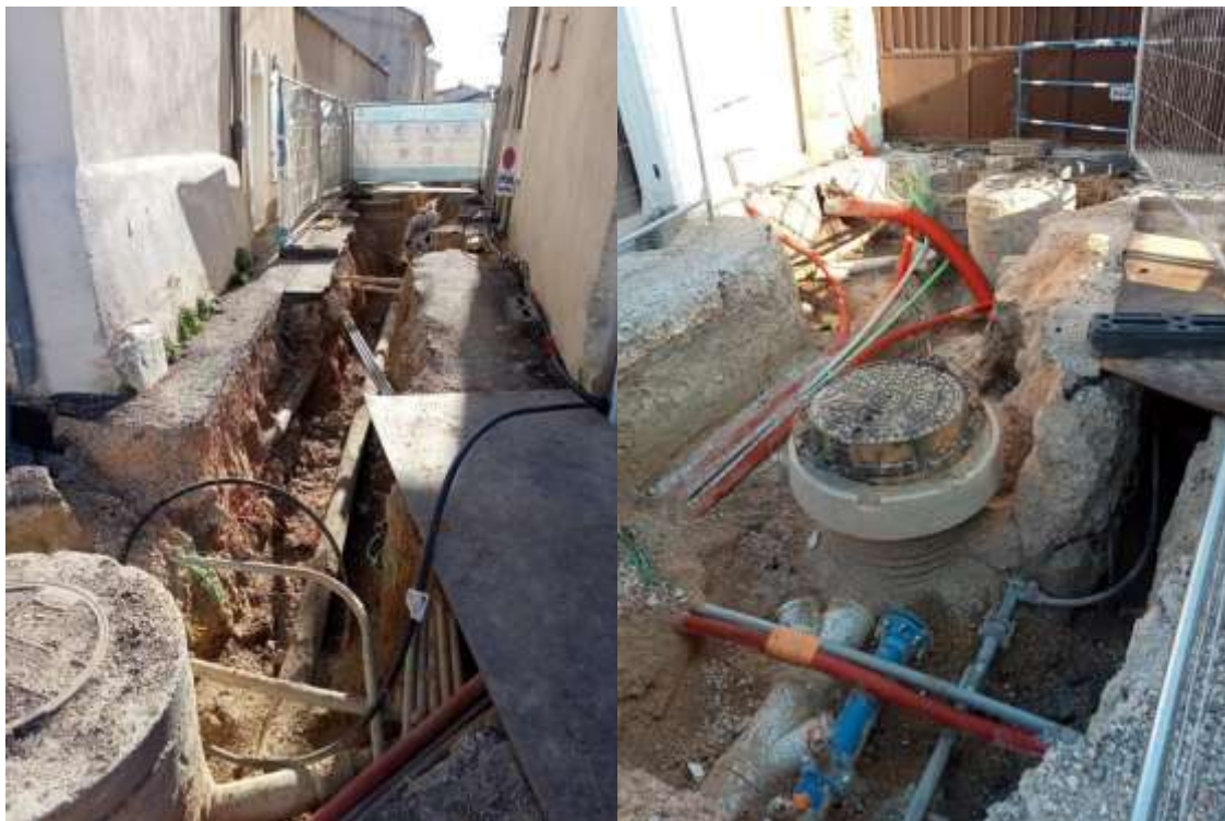
Manduel : Rues Bellecroix, Racine, Fort et Colbert _ Programme de Rénovation de Voirie Renouvellement réseaux humides d'eau potable (300 k€ TTC) et d'eaux usées (360 k€ TTC) Pose des réseaux humides dans un sous-sol très encombré
