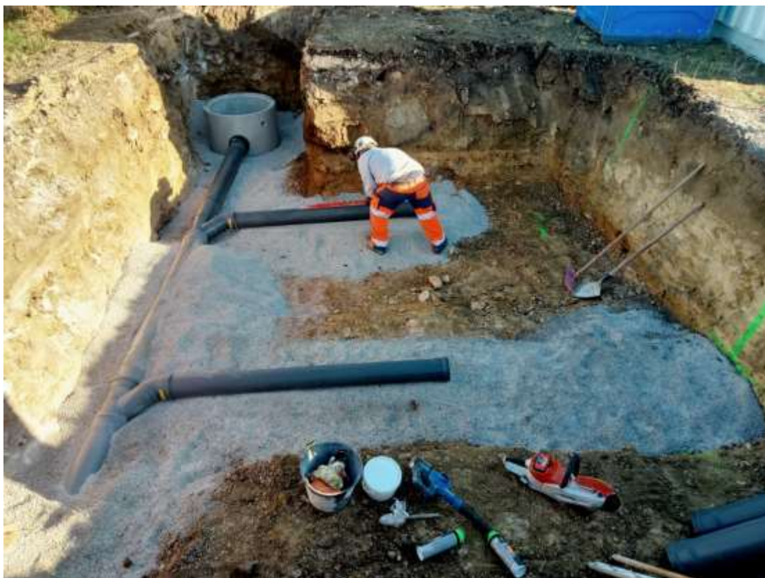
Saint-Chaptes - Chemin du Clapas Extension des réseaux humides d'eau potable (85 k€ TTC) et d'eaux usées (85 k€ TTC) Pose du réseau d'eaux usées et création de deux branchements particuliers
