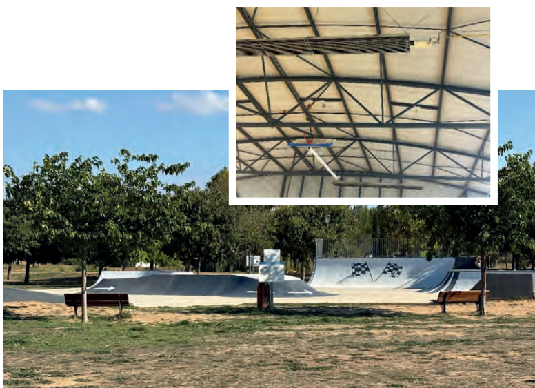
Réfection du « skate Park » par les agents des services techniques cet été. Mise peinture à moindre coût afin d'offrir un cadre plus agréable à nos jeunes pratiquants.
